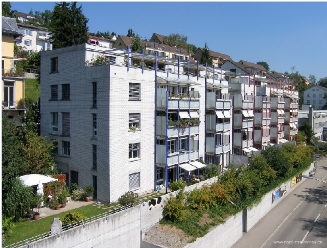
Am Wasser 44, 8049 Zürich
